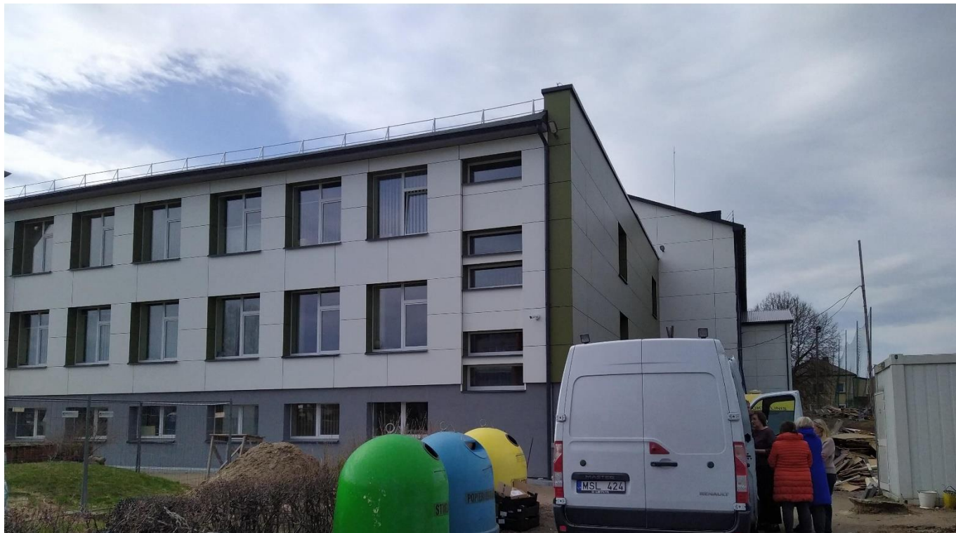
Esamosios būklės fotofiksacija iš planuojamo pristatyti priestato pusės.
