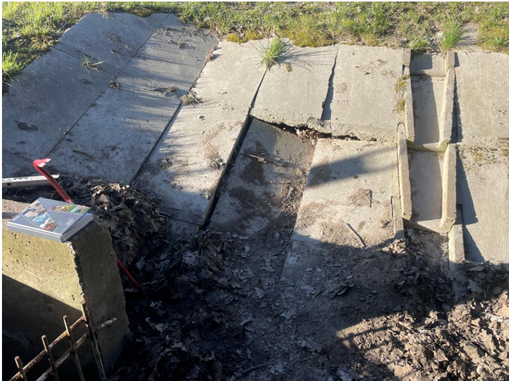
2 pav. Paplautos šlaitų tvirtinimo plokštės P 5-10
