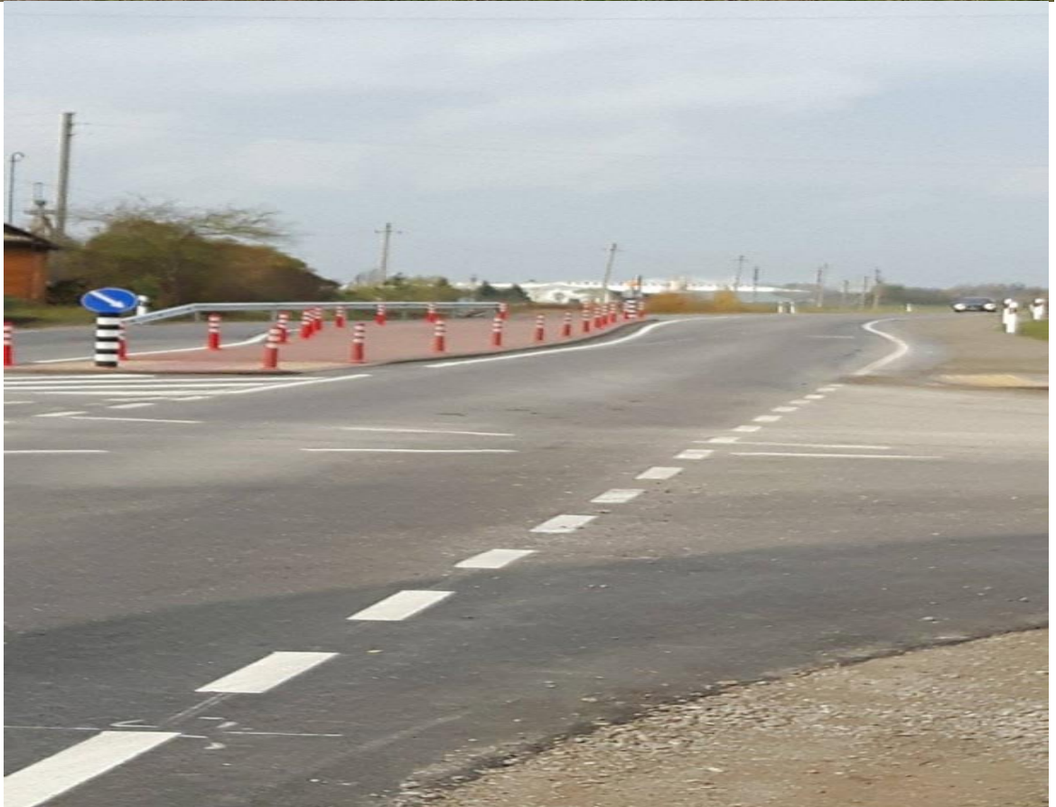
1 pav. 2016 metais baigta melioracijos statinių statyba Kaštonų – Žagarės gatvėse, Gruzdžiuose. 2 pav. F.Vaitkaus g. sankryžoje atlikti rekonstravimo darbai.
